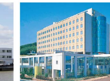
福岡新水巻病院 福岡県遠賀郡・227床
