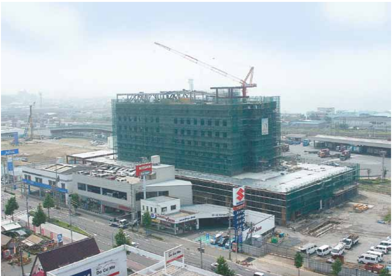
着々と建設が進む新病院（平成19年6月撮影）
